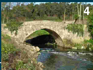
Ponte de Goimil - Custóias
